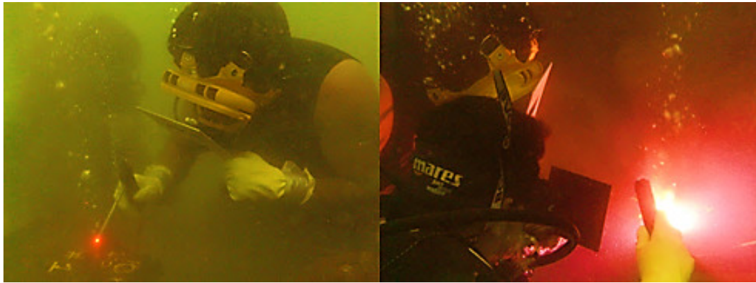
Figura 3.2 Aplicación de soldadura en placas bajo el mar
