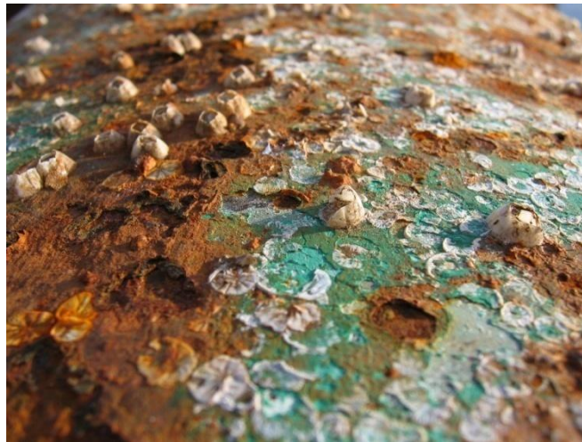
Figura 2.9 Corrosión en Metales [10].
