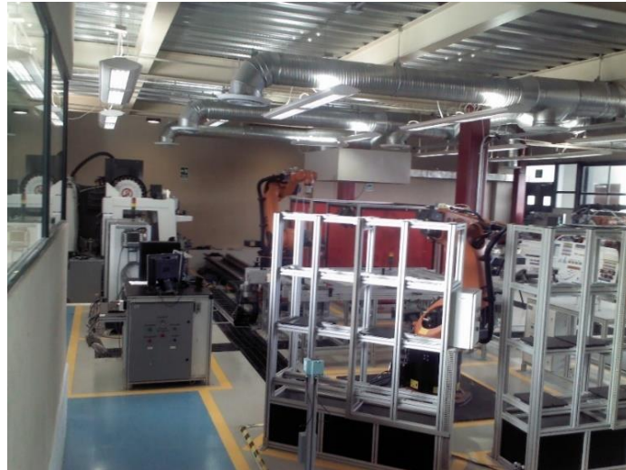
Figura 4.3 Celda de Manufactura Avanzada de COMIMSA
