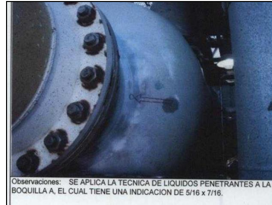
Fig. 2.18 Socavado equipo FA-1201-B, AKAL-JP
