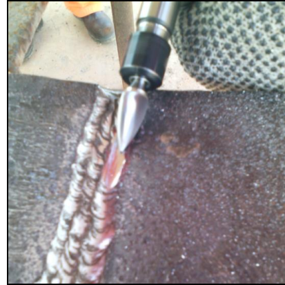
Fig. 3.49. Desbaste interno de la indicación
