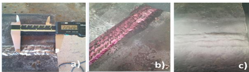
Fig. 3.54 a) Longitud de la soldadura reparada, b) Penetrante en soldadura, c) Aplicación del revelador no encontrando indicaciones relevantes.
