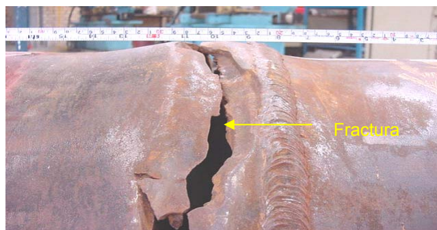
Figura 3.29. Vista cercana del inicio de colapso, así como la fractura generada en esta región [41] .
