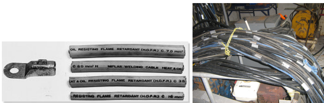
Figura 2.5. Cables conductores de diversos diámetros (cortesía Instituto Tecnológico de Boca del Río).
