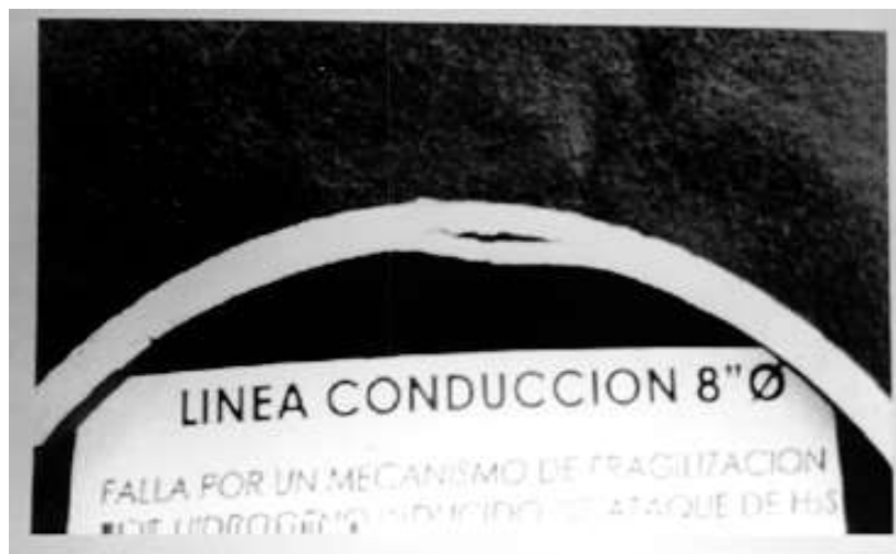
Figura 34. Corte transversal de una tubería dañada por HIC.
