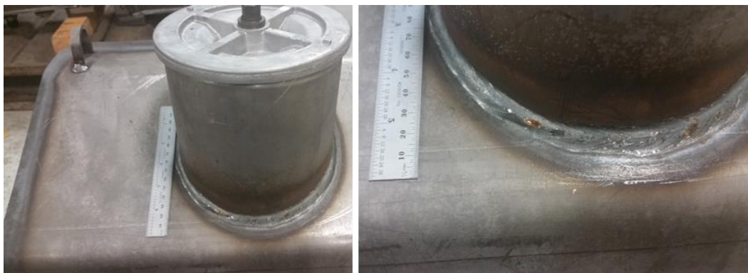
Figura 3.6 Soldadura alrededor de componente tubular (30)
