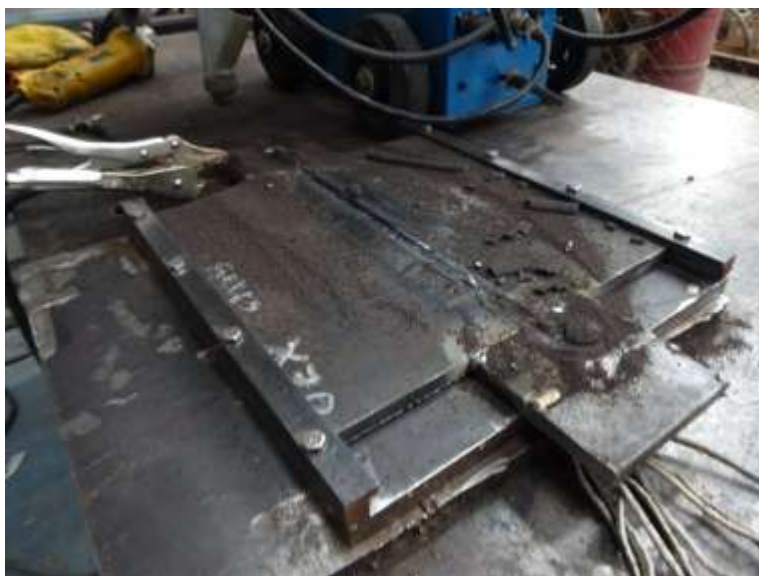
Figura 4.9. Placas de probeta montadas en la brida y fijadas con ocho tornillos en los dos bordes laterales del dispositivo de brida para evitar distorsión después de aplicada la soldadura.
