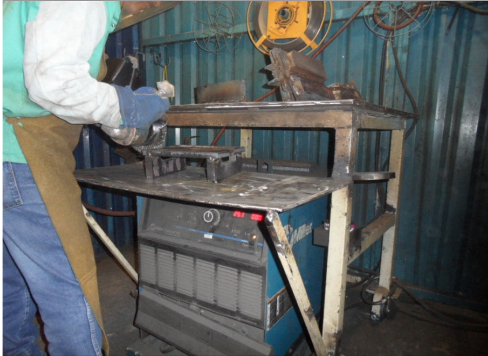
Figura 3.7 Limpieza entre pasos de soldadura con pulidor. Cortesía Equipos de Acuña
