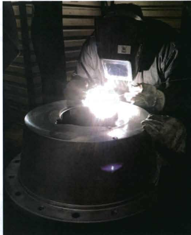
Figura 2. 9 Saneado de componente metálico mediante el proceso convencional GTAW (Cortesía COMIMSA)
