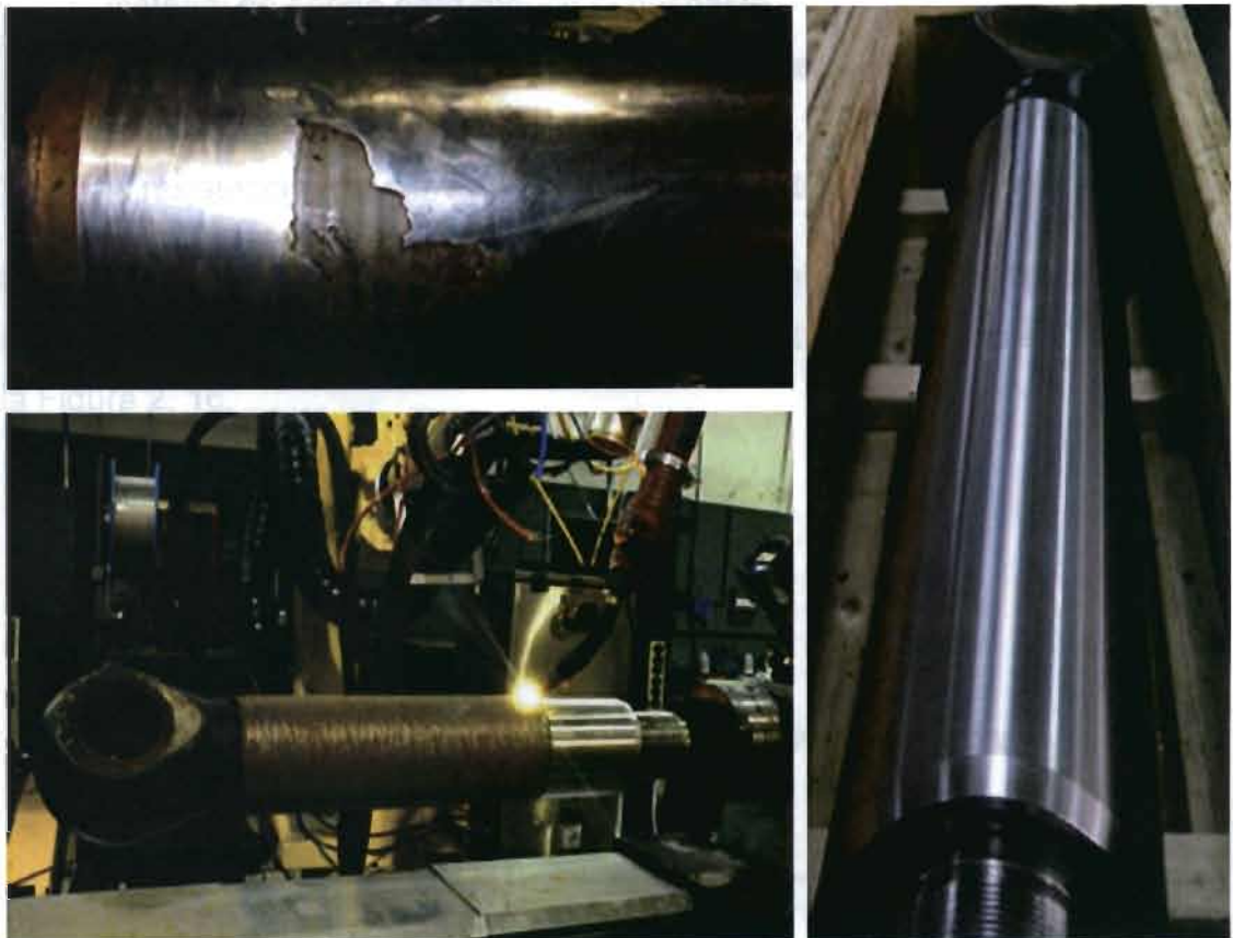
Figura 2. 15 Reparación superficial por láser cladding en componente erosionado (16)
