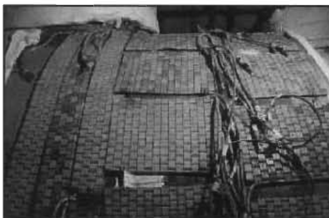
Figura 2.21. Tratamiento térmico en unión de soldadura en un tanque cilíndrico (25)
