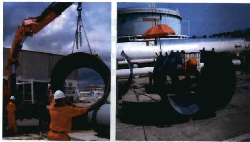
Figura 2.16 y 2.17 Maniobra de recibo de los envolventes metálicos y vista general de secciones de camisa, respectivamente.
