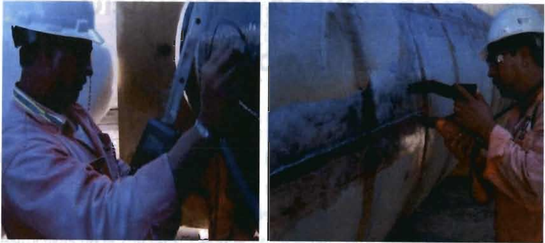
Figura 2.26 y 2.27. Inspección con ultrasonido a soldadura perimetral, e inspección con partículas magnéticas a soldaduras de sello.
