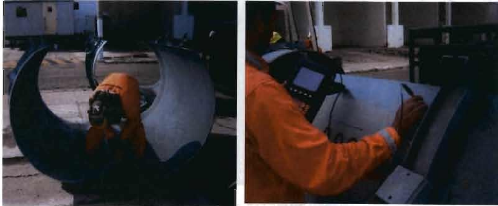
Figura 2.18 y 2.19 Limpieza de biseles e inspección de soldaduras, respectivamente.
