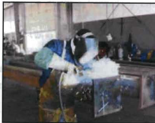
Figura 2.3. Operario de soldadura (6).
