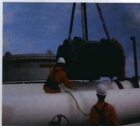
Figura 2.21 Instalación de secciones de camisa.
