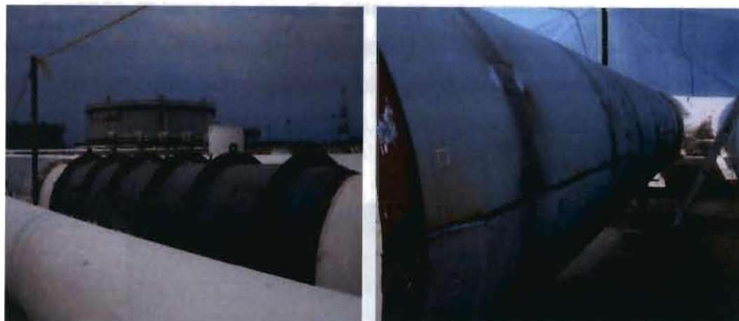
Figura 2.22 y 2.23 Vista general y conformado del envolvente metálico, respectivamente.
