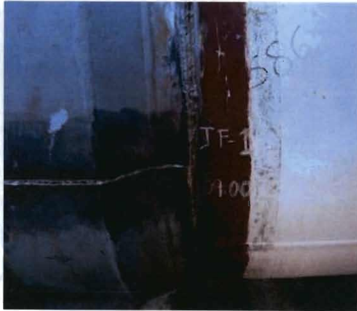
Figura 2.25 Vista de Soldadura de Filete.
