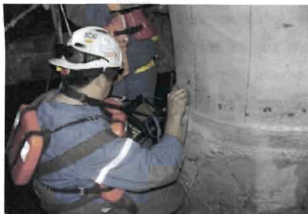
Figura 2.17. Inspección con el método de ultrasonido a tubería de conducción [8]
