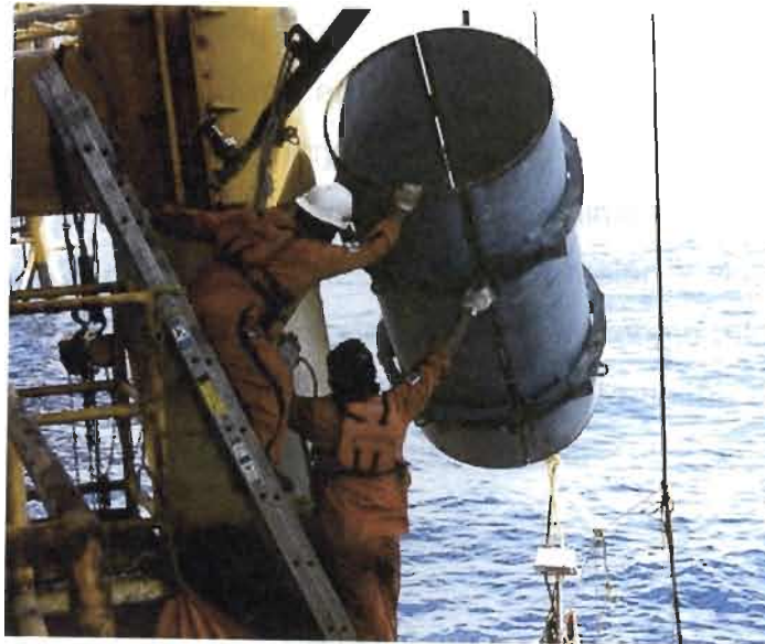
Figura 2.9. Instalación de una Envolvente Metálica [6, 7].
