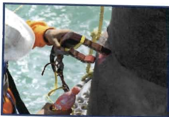
Figura 2.16. Inspección con el método de partículas magnéticas a tubería de conducción [8]
