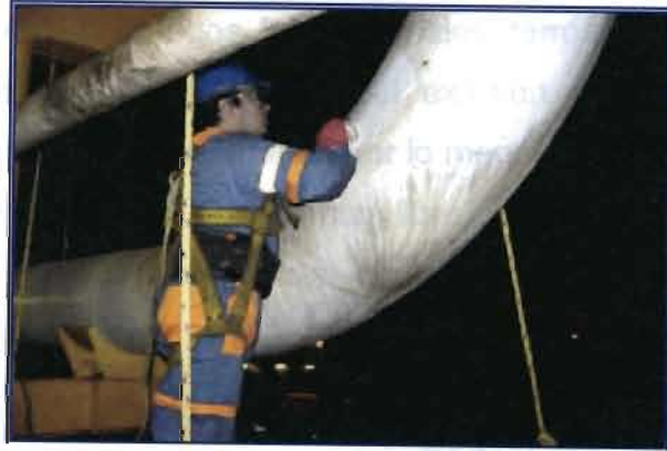
Figura 2.15. Inspección visual a tubería de conducción [5]
