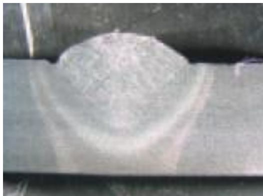
Figura 2.15. Socavado en el pie del cordón de soldadura. [22]
