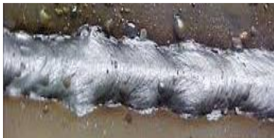
Figura 2.14 Discontinuidad tipo traslape. [19].
