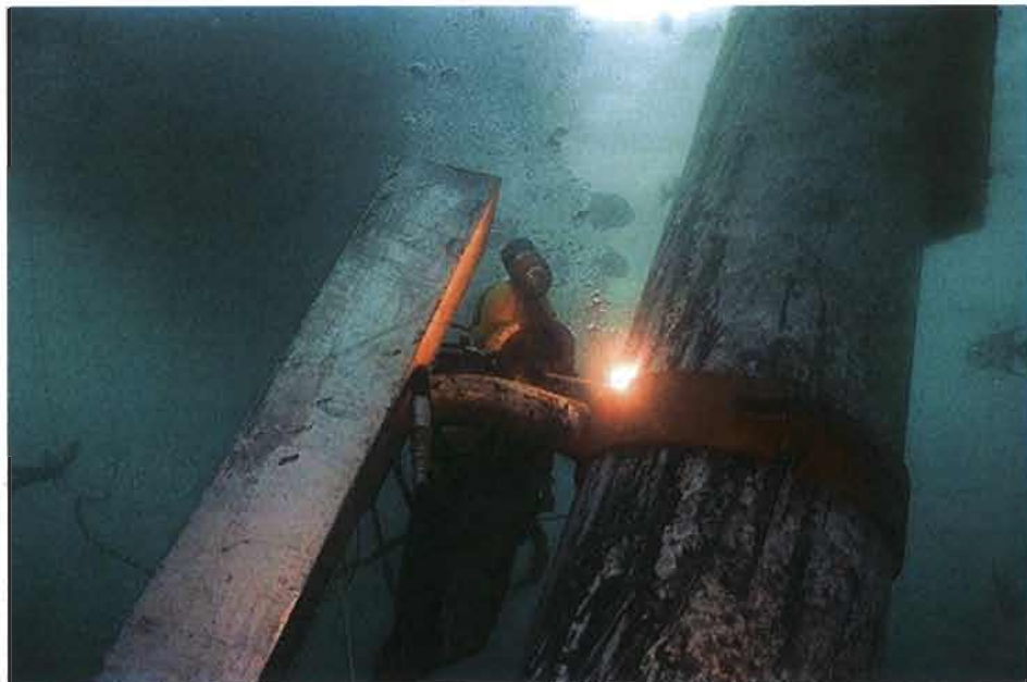
Figura 1.1 Proceso de soldadura por MMAW en pierna de plataforma [1]
