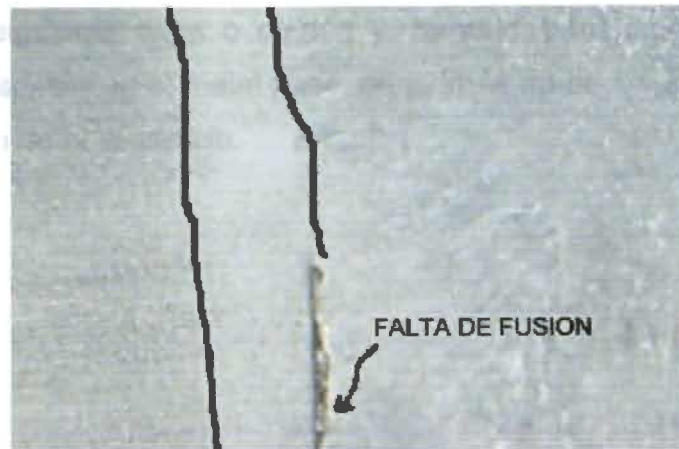
Figura 5.9.- Soldadura con falta de fusión en superficie.
