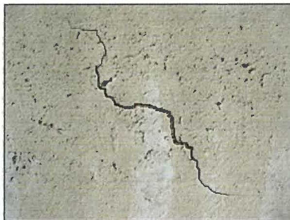
Figura 5.10.- Grietas en una soldadura.
