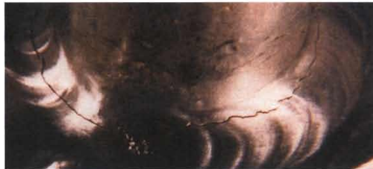
Figura 5.1 Soldadura fracturada en frío
