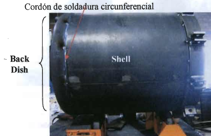
Figura 11. Aspecto general del filtro de aceite en proceso de soldadura. (Cortesía de Camfilfar)
