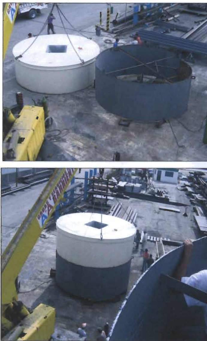
Figura12. Fotografía que muestra montaje de un recipiente por medio de grúa fuera de la planta.
