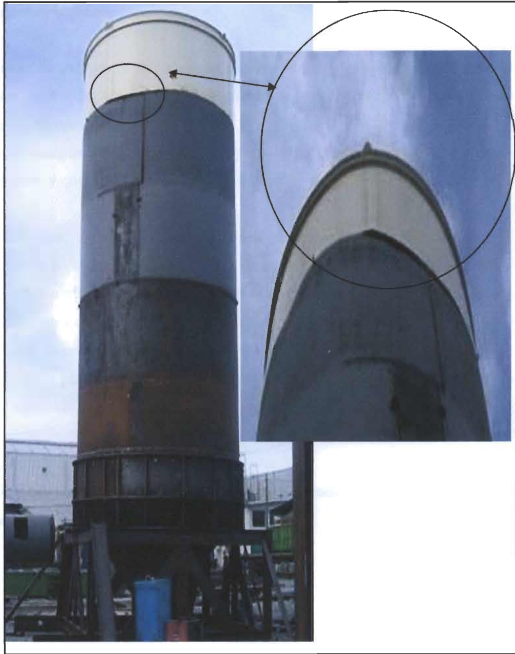
Figura 20. Fotografía que muestra error en las dimensiones de uno de los componentes para su ajuste con el resto del recipiente.
