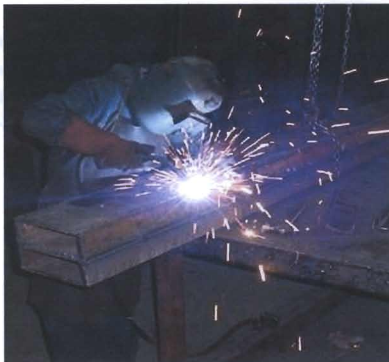
Figura 18. Aplicación de soldadura por proceso GMAW.
