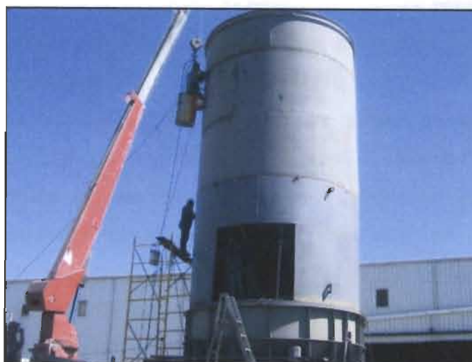
Figura 17. Aplicación de soldadura en campo.
