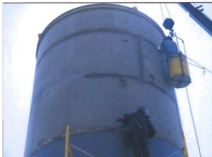
Figura 19. a) Armado del cono y base, b) instalación de entrada al cono c) armado del cono al cuerpo.
