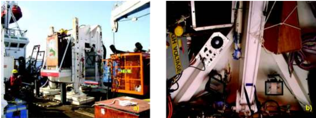
Figura 2. 3 Soldadura seca: a) muestra el hábitat seco b) se muestra el interior del hábitat seco (2).
