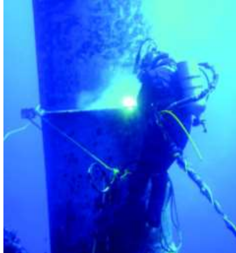
Figura 2. 2 Soldadura húmeda del refuerzo del anillo de una estructura tubular (2).
