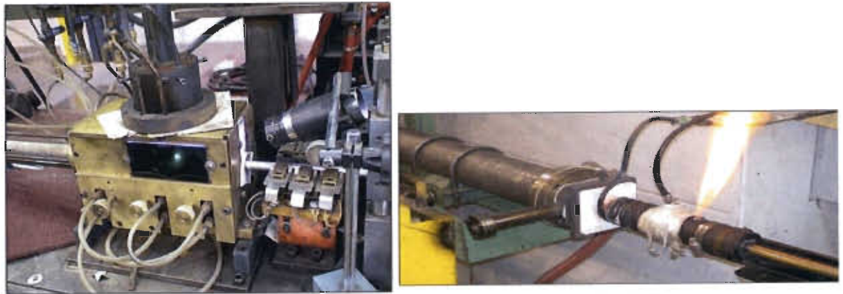
Figura 2.17. a) Aplicación de la soldadura. b) Etapa de tratamiento térmico (Tubos Samuel S.A de C.V.).
