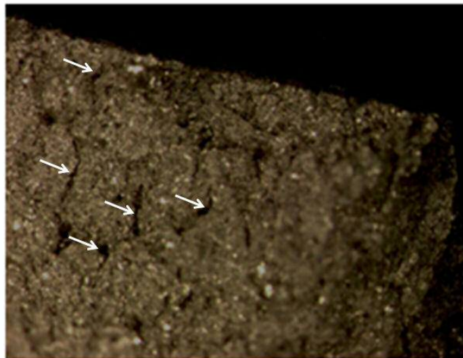
Figura 1. Imágenes por estereoscopio de la superficie de fractura del álabe conteniendo grietas observadas a ampliaciones de 25 X.
